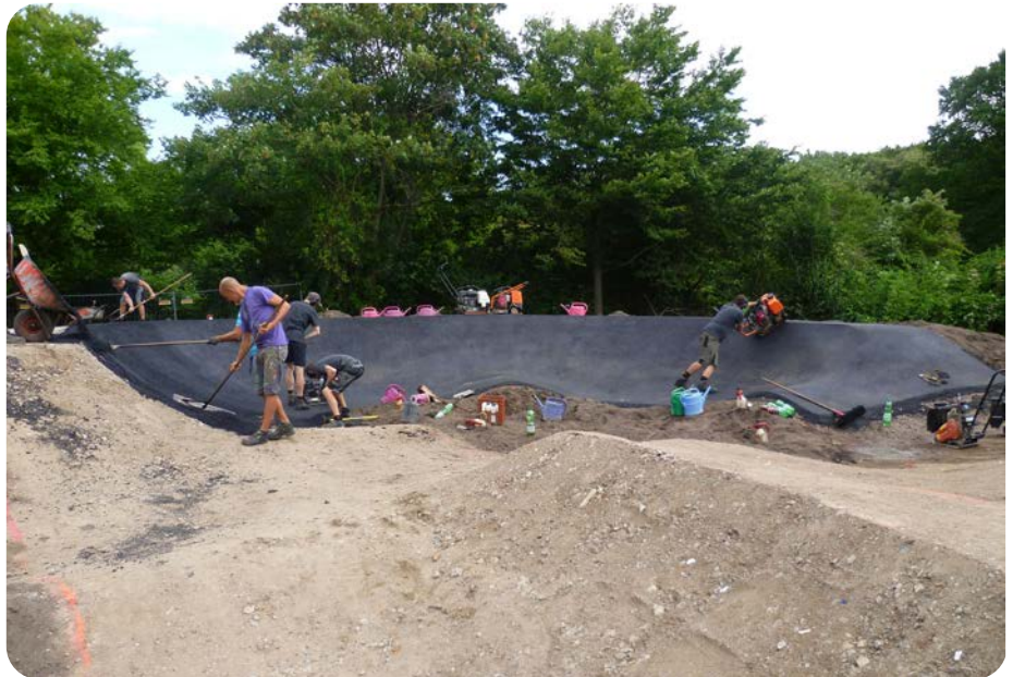
Pumptrack-Anlage wird asphaltiert
